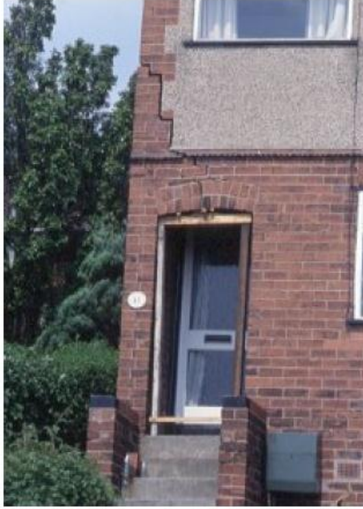
الشكل 2 مثال عن الأضرار التي تسببها الترب الضعيفة على الأبنية
