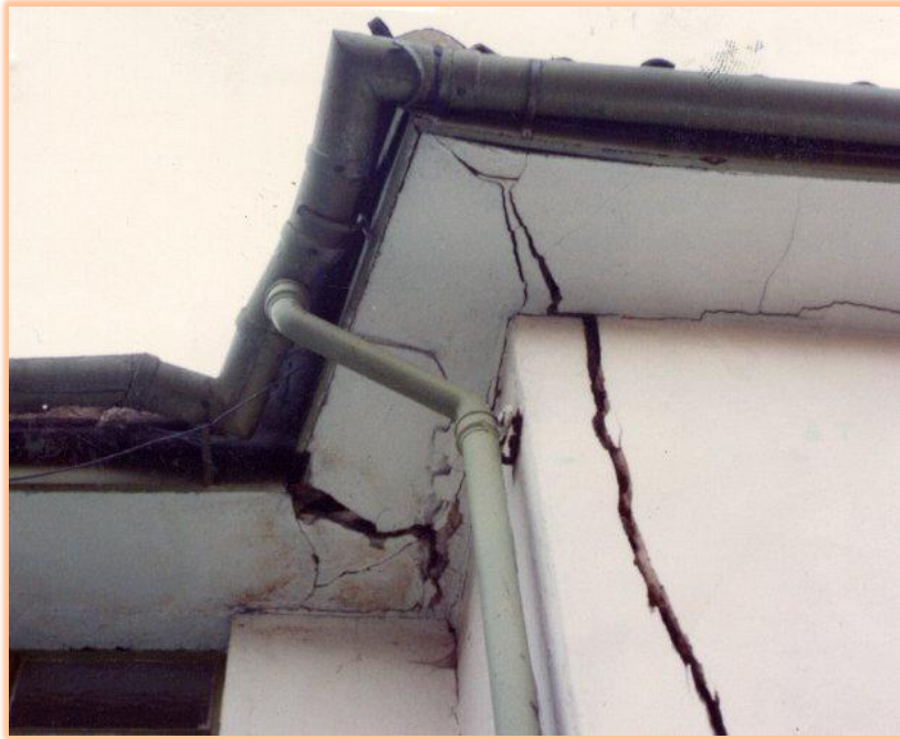
الشكل 1 مثال عن الأضرار التي تسببها الترب الضعيفة على الأبنية
