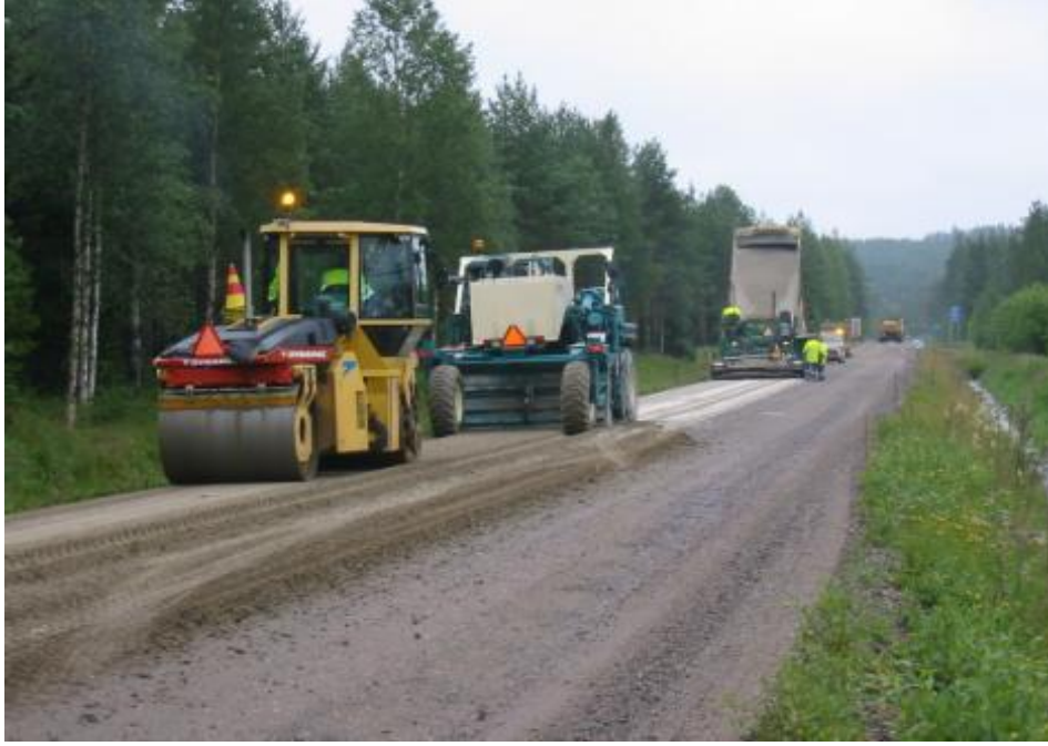
الشكل 8 التحسين أثناء تنفيذ الطريق حيث يتم فرش المادة الرابطة ورصها مع عمليات تنفيذ الطابق الترابي
